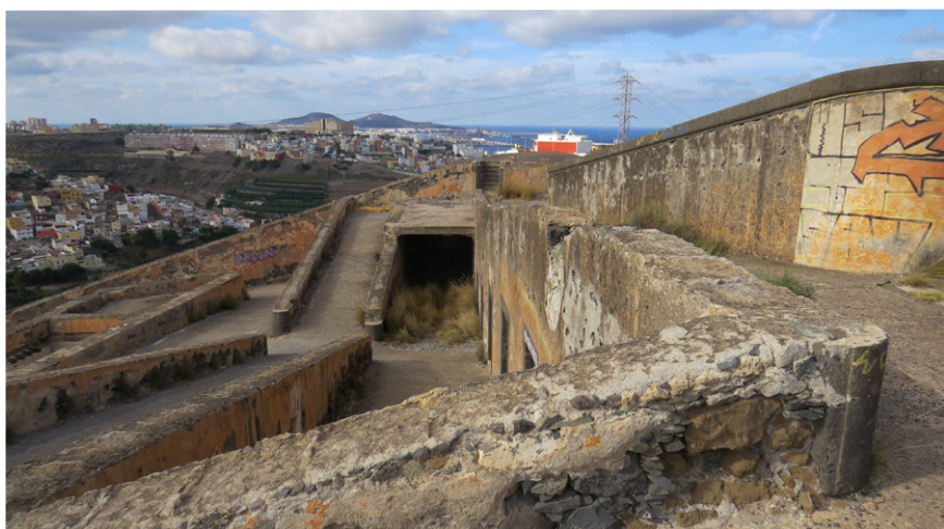
Batería de San Juan. Estado actual.
